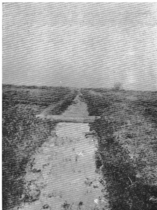
Foto. Núm. 2.— Dren para disecar pantanos en Chinchorro.
