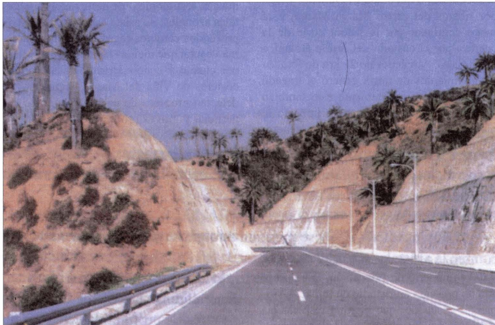
Fig. 14. Para construir la autopista, se cortó o abrió un sector de colinas, destruyendo decenas de palmas.
