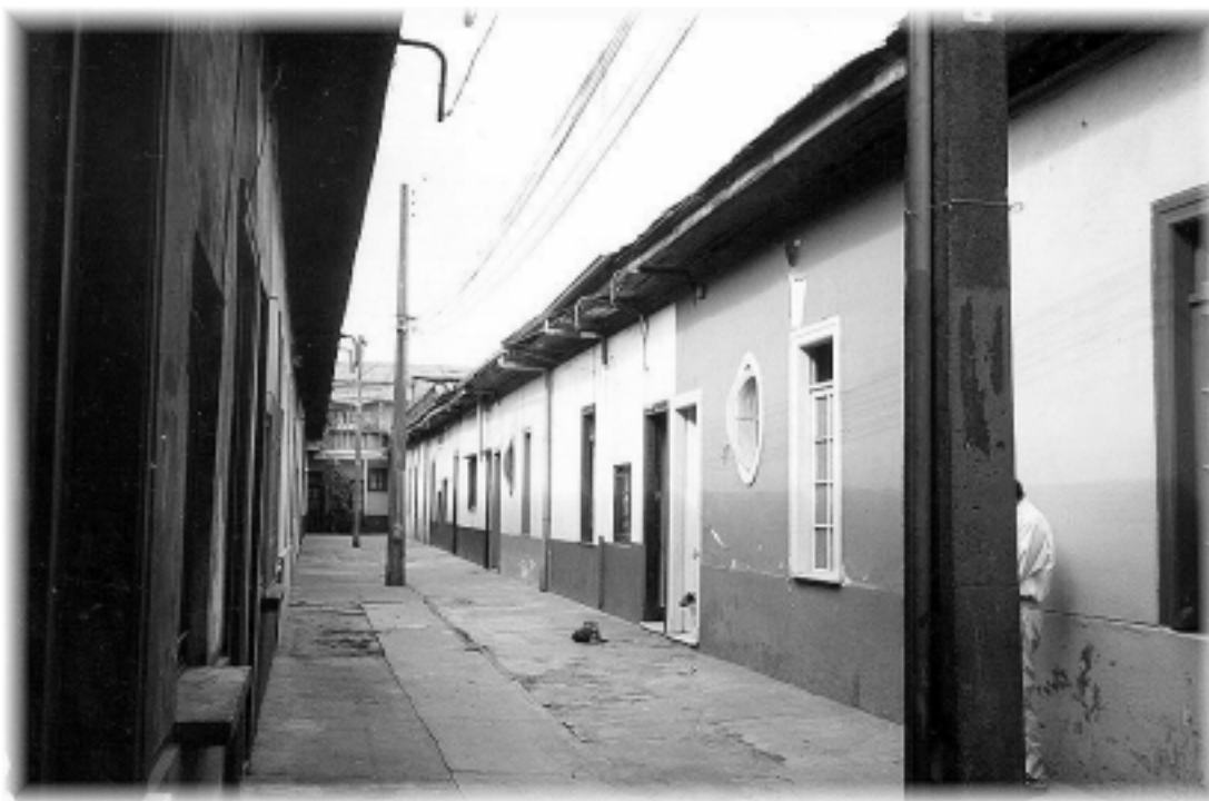
FOTO Nº 1. CITÉ EN CALLE GORBEA. ESTADO DEL CITÉ ANTES DE APLICARSE EL PROGRAMA DE RESTAURACIÓN DE CÍTÉS Y PASAJES DE LA MUNICIPALIDAD DE SANTIAGO. FUENTE: CORDESAN.
