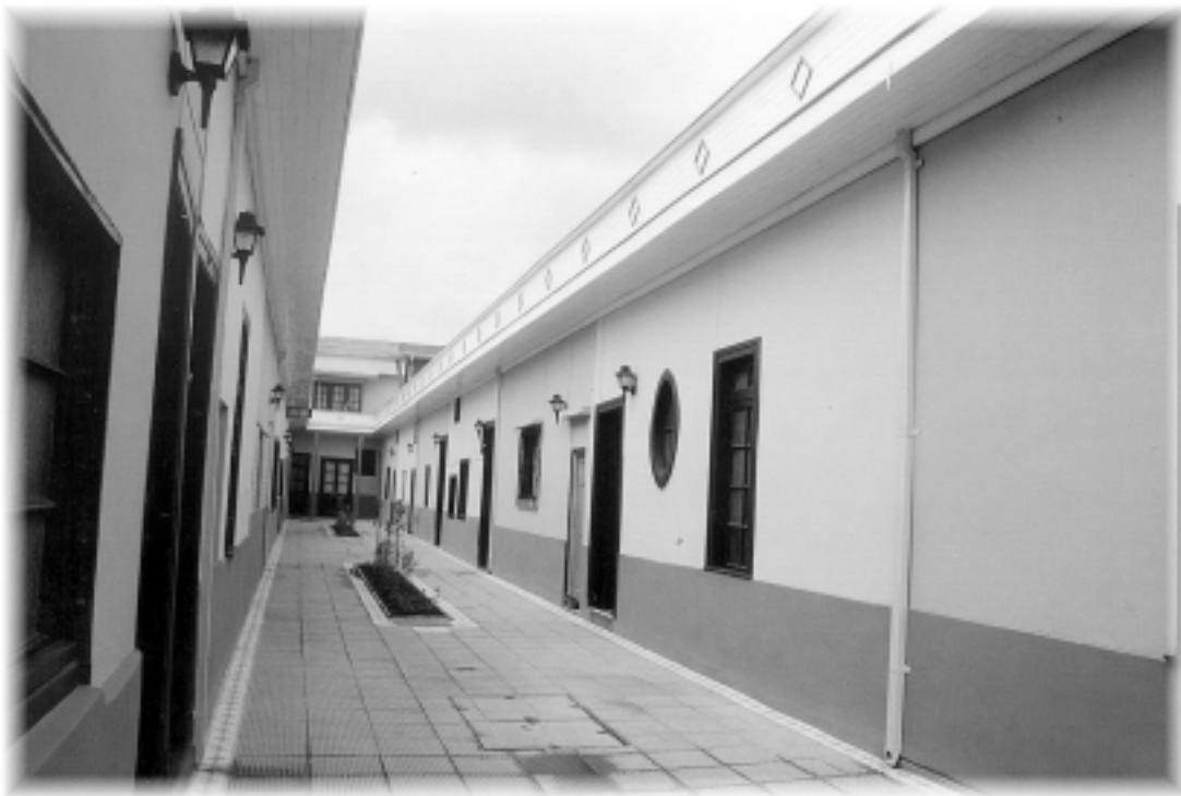
FOTO Nº 2. CITÉ EN CALLE GORBEA. ESTADO DEL CITÉ DESPUÉS DE APLICARSE EL PROGRAMA DE RESTAURACIÓN DE CITÉS Y PASAJES DE LA MUNICIPALIDAD DE SANTIAGO. FUENTE: CORDESAN.
