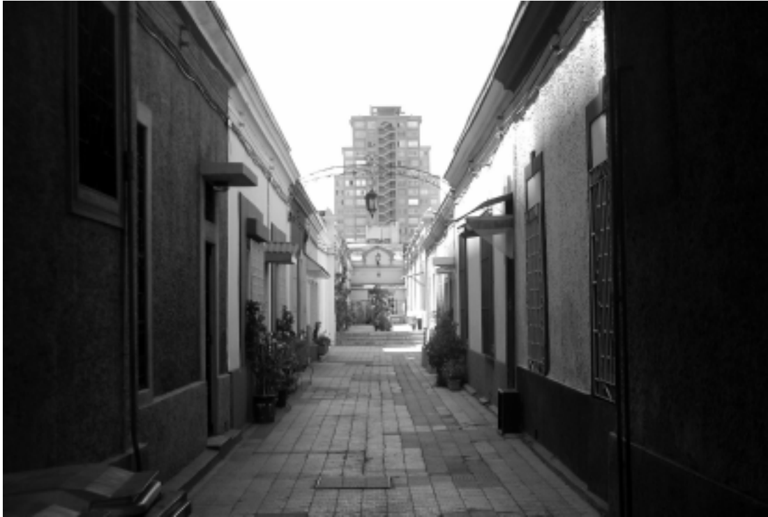
FOTO Nº 5. CITÉ SAN FRANCISCO. VISTA DEL ESPACIO COMUNITARIO DESDE LA CALLE. AL FONDO SE OBSERVA EL CAMBIO EN LA DENSIDAD Y ALTURA DE EDIFICACIÓN.
