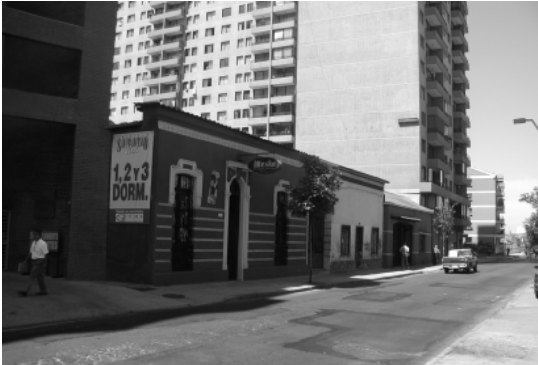
FOTO Nº 6. UBICACIÓN DEL CITÉ EN SU ACTUAL ENTORNO BARRIAL.
