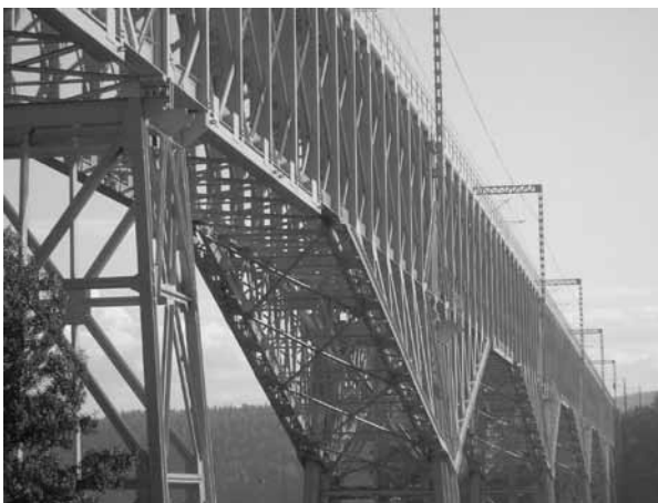
Figura 1. Viaducto del Malleco, 1872. Schneider et Cie. O Le Creusot. Fuente: Fotografía de Pablo Fuentes Hernández.
